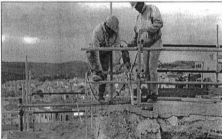
OPERAI MENTRE LAVORANO AL RECUPERO EDILIZIO DI UN PALAZZO
